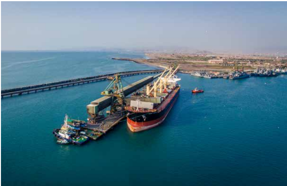
Figura 17 – Terminal de minerales Transportadora Callao – Fuente: APN
