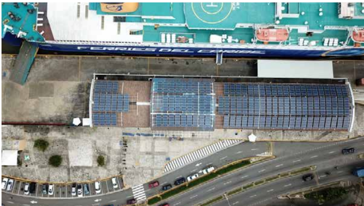
Figura 39 – Paneles solares de la Planta Fotovoltaica (PV) instalados en el techo del edificio de la terminal de pasajeros de Puerto de Sansoucí – Fuente: Puerto de Sansoucí
