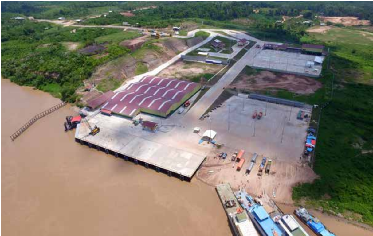
Figura 16 – Terminal Portuario de Yurimaguas - Nueva Reforma – Fuente: APN
