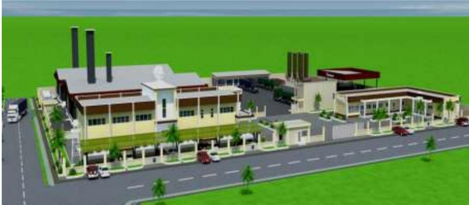
usine composée d'une unité de traitement des boues des hydrocarbures solides d'une capacité brute de 10080 tonnes et d'une unité de recyclage des huiles usées d'une capacité de 116 640 tonnes ».
