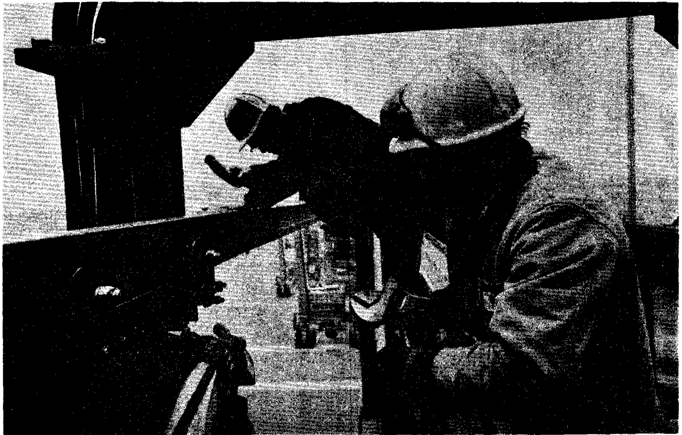
Reparaciones sobre el terreno
