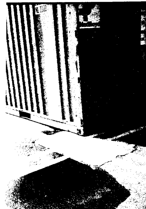
Dans ce système mixte, de petits supports en béton sont placés pour recevoir les pièces de coin des conteneurs. Notez le tassement différentiel qui a provoqué une accumulation d'eau de pluie.
