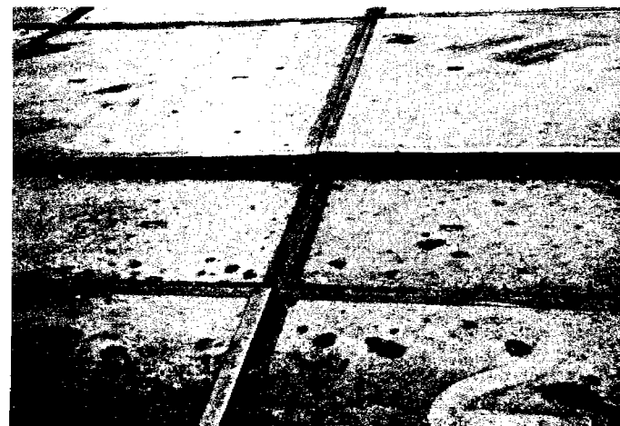
L'affaissement inégal des dalles ("tassement différentiel") a souvent posé un problème dans les ports; non seulement il constituait un danger, mais il occasionnait aussi des dégâts au matériel, sans compter que les dalles elles-mêmes pouvaient se rompre et favoriser l'accumulation d'eau.
