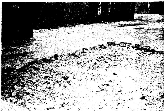
Les réparations des revêtements en béton coulé sur place sont coûteuses et perturbent les activités.
