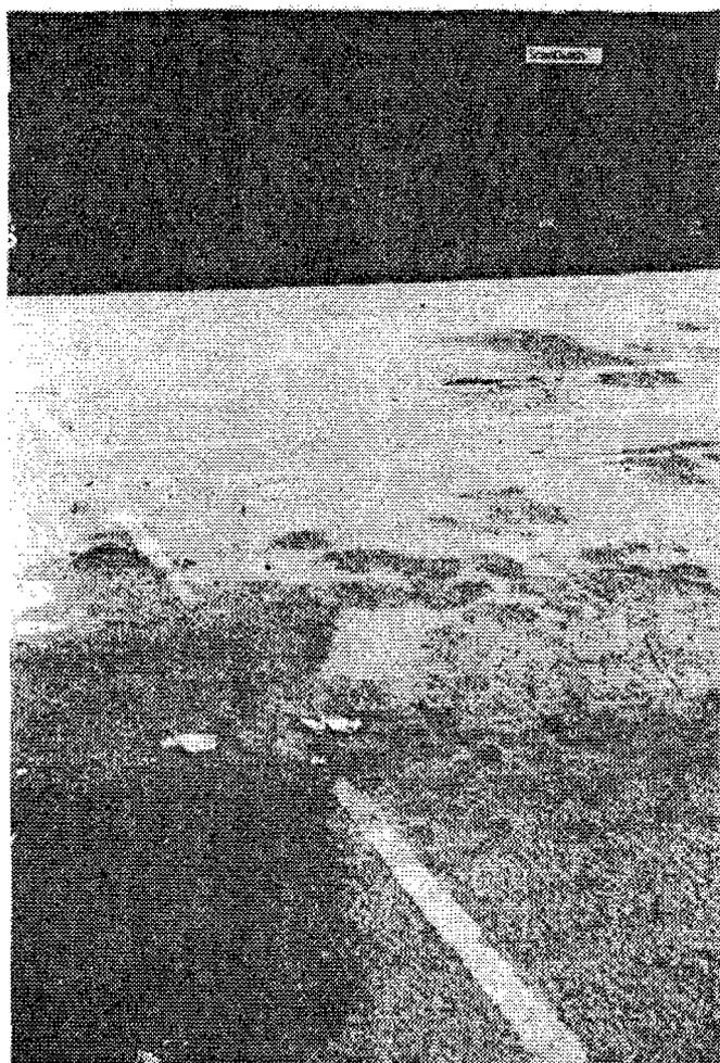
Degradación del asfalto como consecuencia de derrames de aceite del equipo de manipulación.
