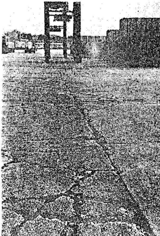
No es raro que pavimentos expresamente diseñados para la manipulación de contenedores cedan. Este pavimento de hormigón no reforzado tiene cuatro años.
