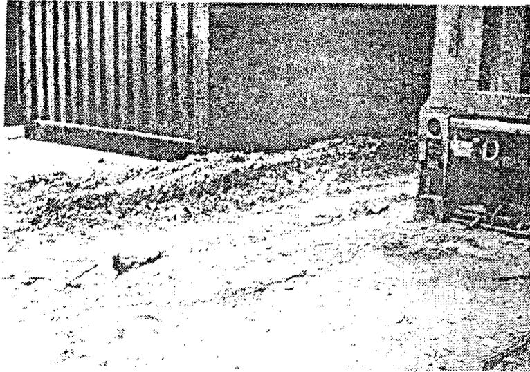
Fallo del pavimento bituminoso en los pasillos estrechos que separan las pilas de contenedores, como consecuencia del movimiento canalizado de vehículos de pórtico alto. El pavimento se había diseñado para las cargas, menos pesadas, de la manipulación general de mercancías.
