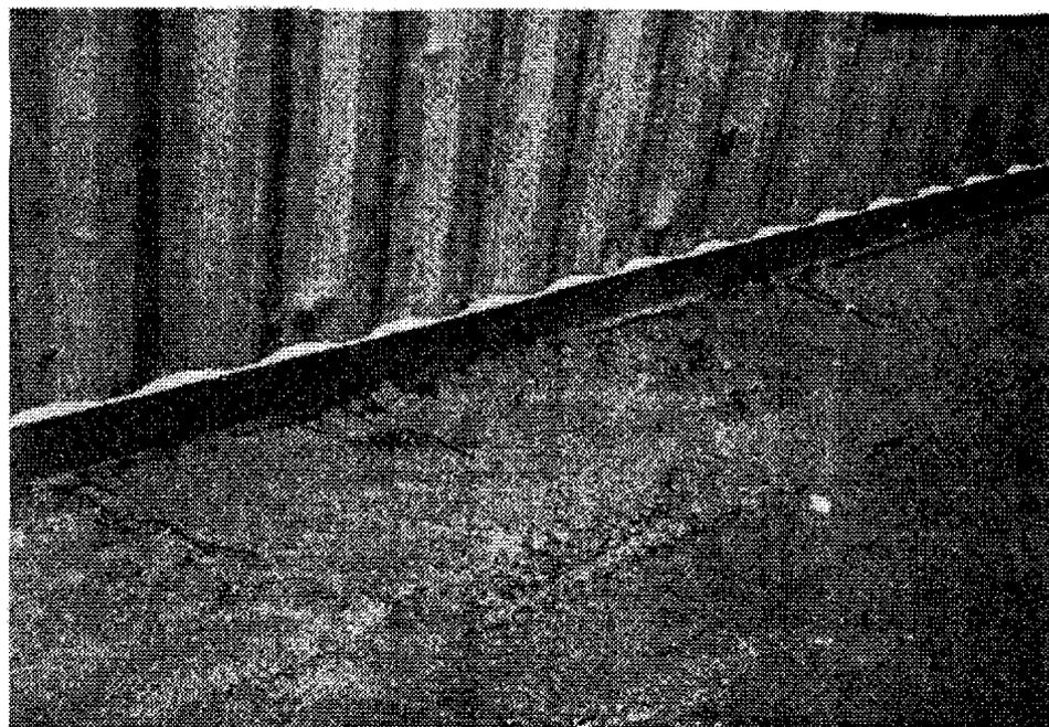
La indentación de las piezas fundidas de las esquinas hace que entren en contacto la parte inferior del contenedor y el pavimento. Tanto el contenedor como el pavimento pueden resultar dañados.
